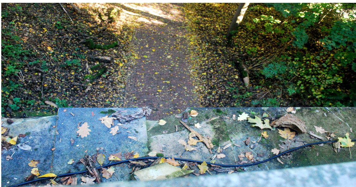
Fot.17.,18.,19. – Na fotografiach widoczne od góry ubytki w nakrywach piaskowcowych gzymsu wschodniego. Krawędzie ubytków należy wyrównać poprzez wycięcie uszkodzonych miejsc i wstawienie fleków z piaskowca odpowiadającego grubością i kolorystyką płytom istniejącym.
