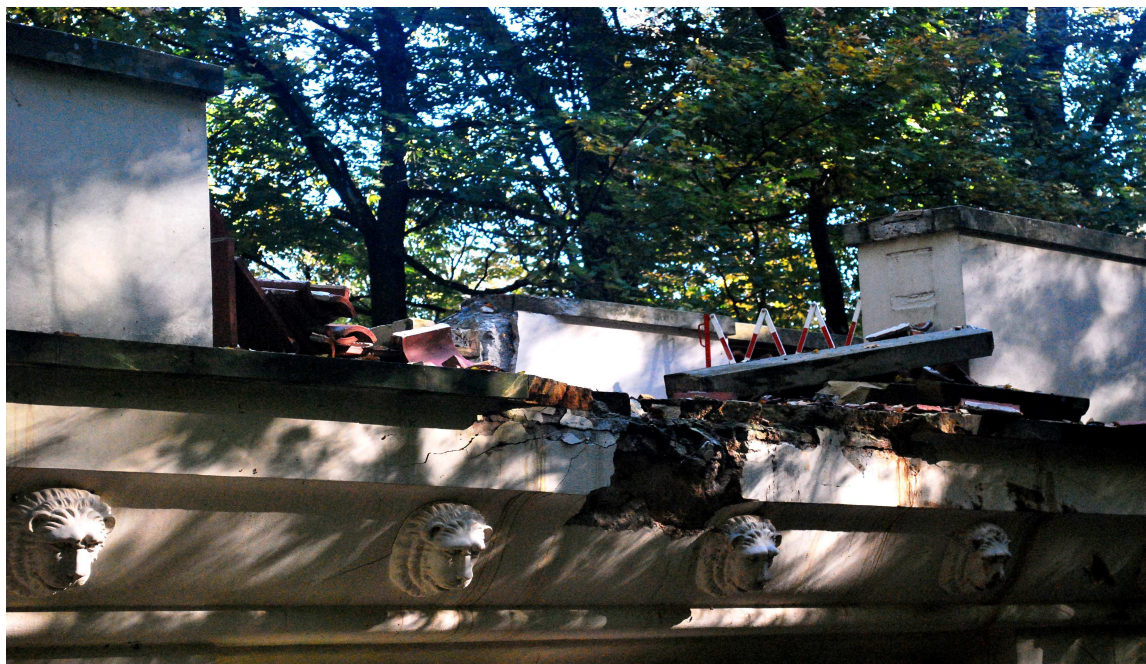
Fot.12. – Widoczny fragment gzymsu pod zniszczoną balustradą od strony zachodniej. Fragmentaryczne uszkodzenia ceglanej konstrukcji gzymsu, konieczne do przemurowania, uzupełnienia wyprawy tynkarskiej i wstawienia zniszczonych fragmentów piaskowcowej nakrywy
