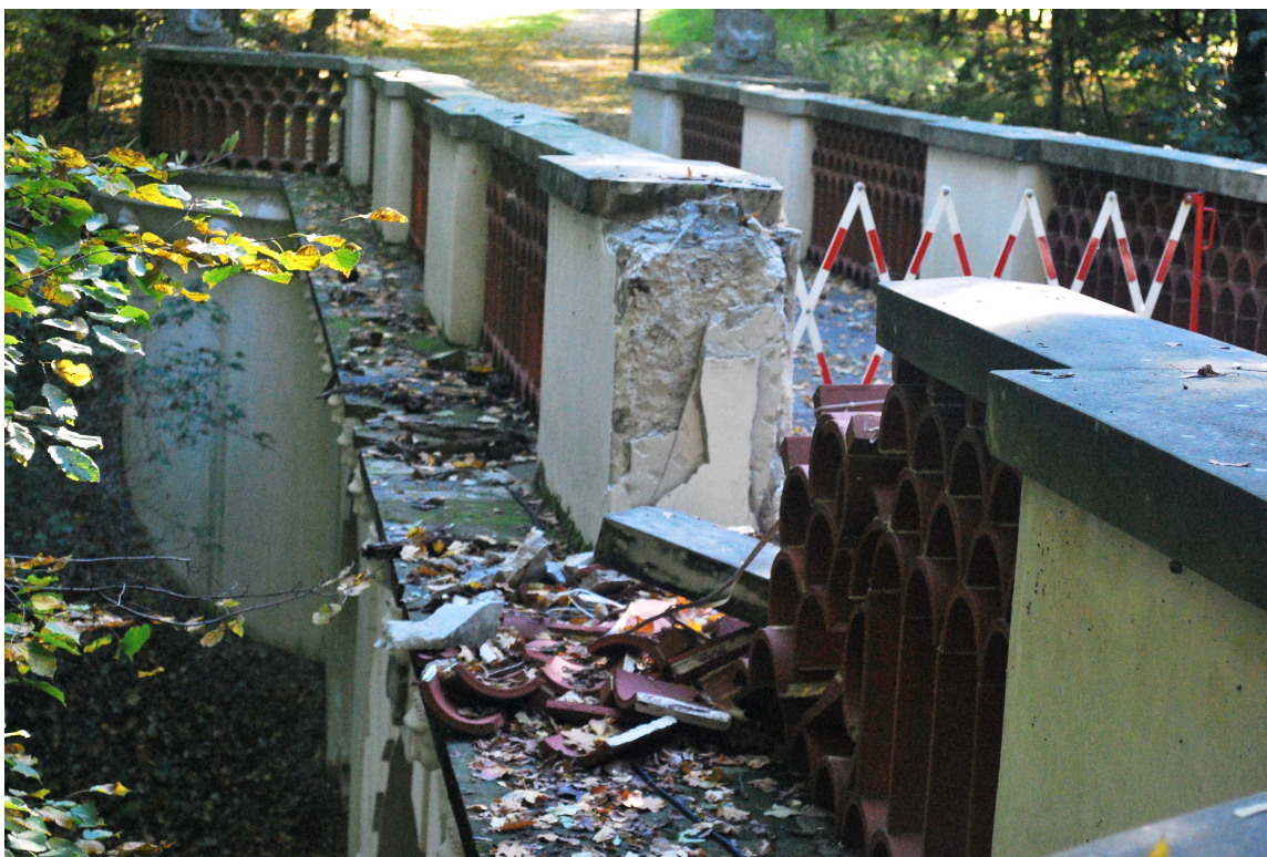
Fot.16. Widoczne od strony zewnętrznej uszkodzone przęsła balustrady wschodniej oraz okładziny piaskowcowe gzymsu.
