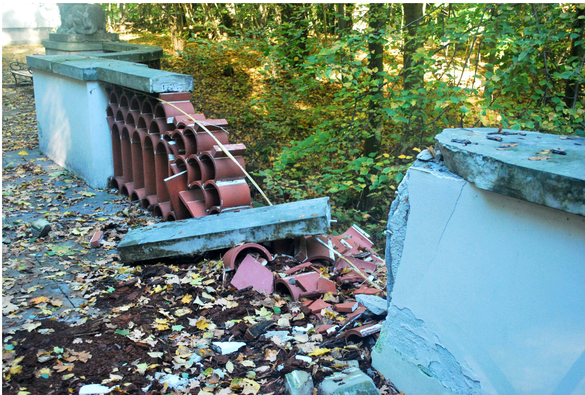
Fot. 6. Zniszczenia przęsła balustrady wschodniej. Zniszczeniu uległo 2/3 przęsła od strony południowej. Ceramiczne kształtki balustrady od strony północnej nie zostały zniszczone. Zachowała się spoczywająca na nich kamienna nakrywa.
