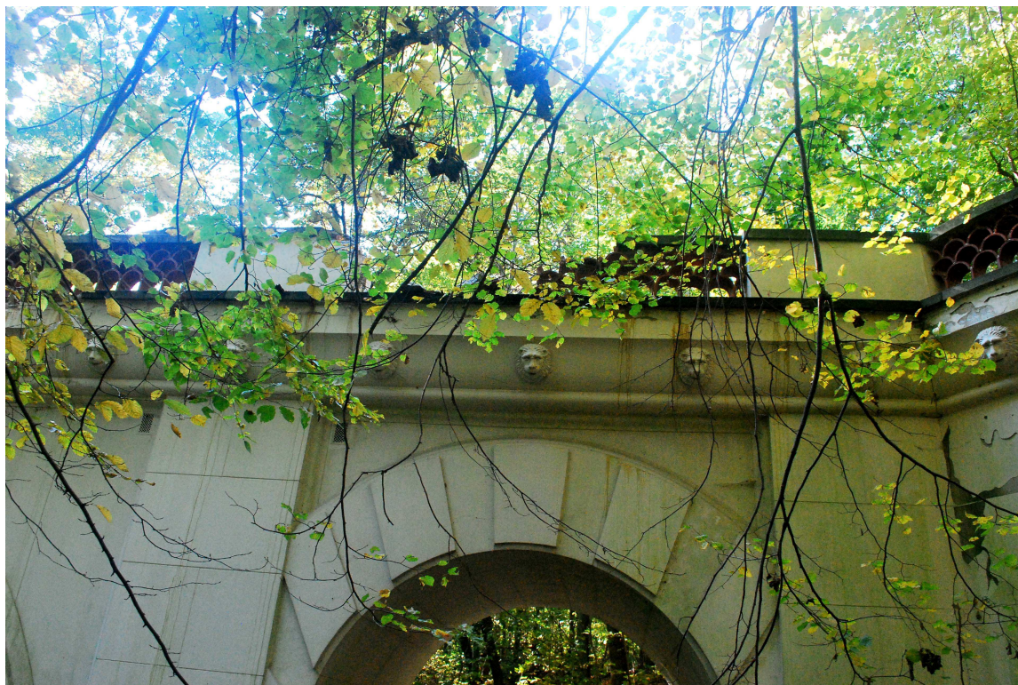
Fot14. – Widoczny fragment gzymsu pod zniszczoną balustradą od strony wschodniej – przeszło nad wąską arkadą. W miejscu tym nie występują uszkodzenia w murowanej konstrukcji i w piaskowcowych nakrywach gzymsu. Uszkodzenia występują tylko w wyprawie tynkarskiej.
