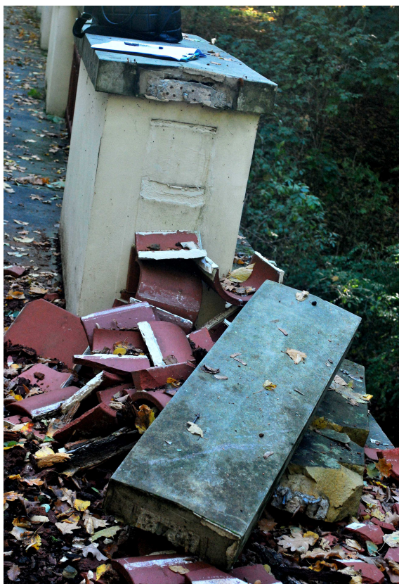
Fot. 4. – Południowy skraj przęsła. W tynku słupka widoczne miejsca zamontowania ceramicznych elementów wypełnienia i w kamiennej nakrywie miejsce zamontowania nakrywy zniszczonego przęsła.
