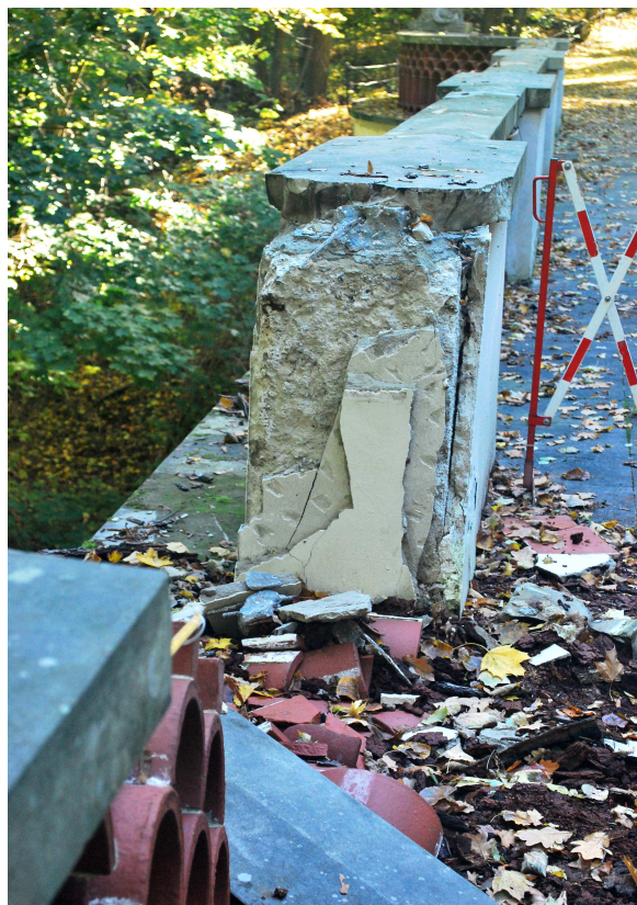
Fot.11. Widoczne zniszczenia południowego słupka konstrukcyjnego balustrady. Skraj słupka przemurować, uzupełnić zniszczone fragmenty piaskowcowej balustrady.
