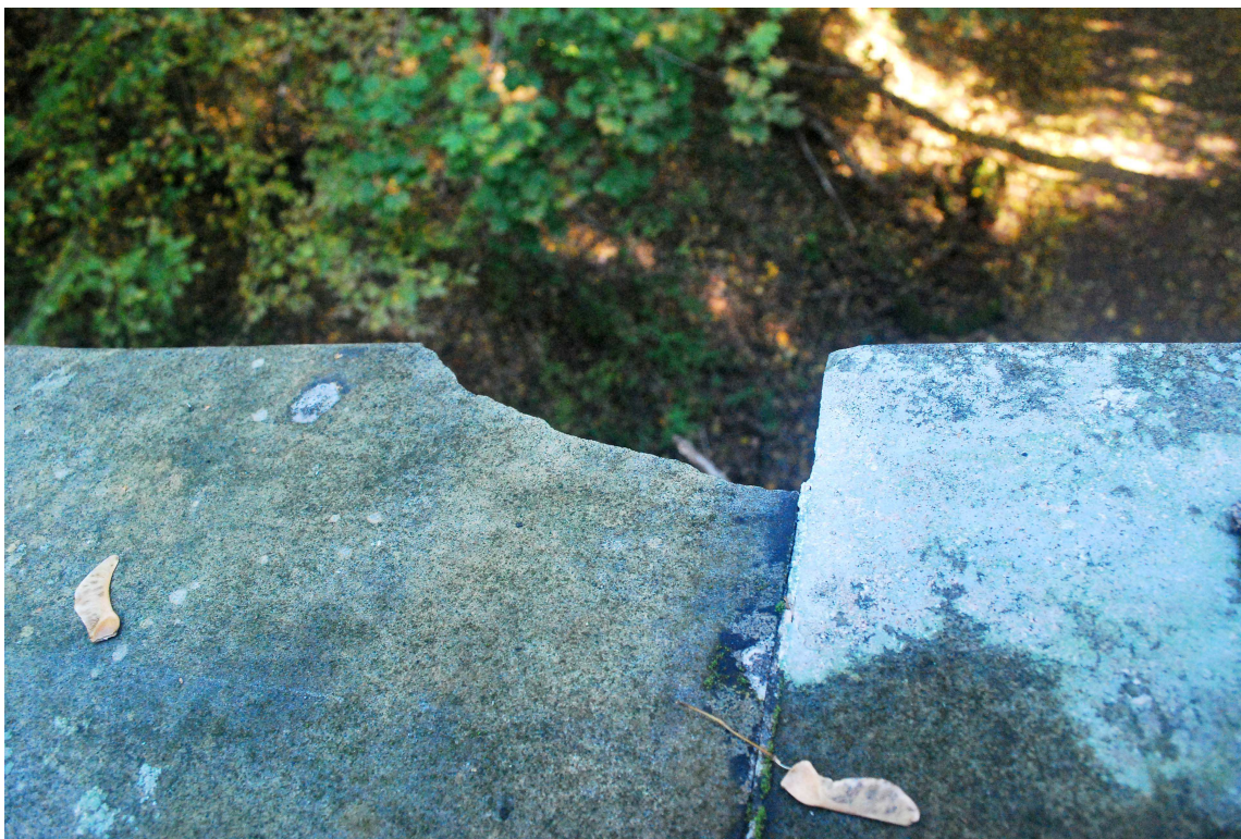
Fot.20. – Uszkodzona piaskowcowa nakrywa parapetu balustrady wschodniej mostu. Uszkodzenie zlokalizowane jest nad przęsłem balustrady sąsiadującym od strony południowej z przęsłem zniszczonym. Krawędzie ubytków należy wyrównać poprzez wycięcie uszkodzonych miejsc i wstawienie fleków z piaskowca odpowiadającego grubością i kolorystyką płytom istniejącym.
