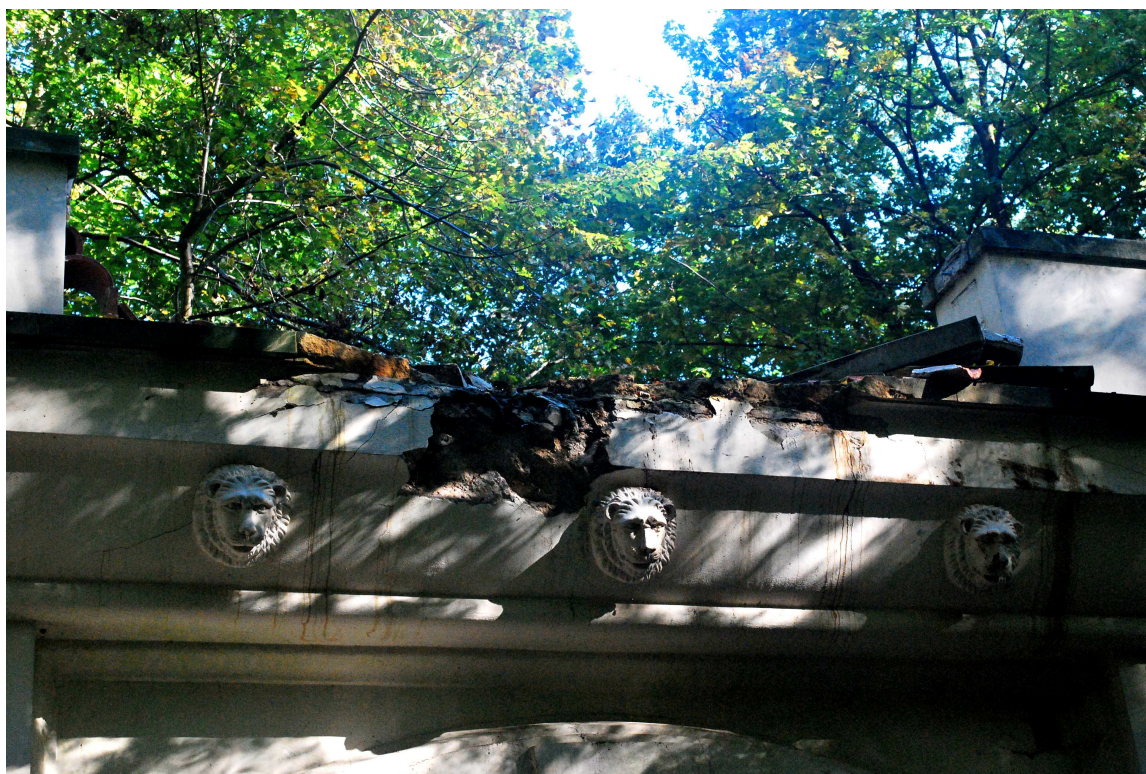
Fot.13. – Widoczne z wyższej perspektywy ubytki w nakrywach kamiennych gzymsu. Należy je uzupełnić wstawiając fragmenty płyt wycięte z piaskowca o grubości odpowiadającej płytom istniejącym i odpowiadającej kolorystyce kamienia.
